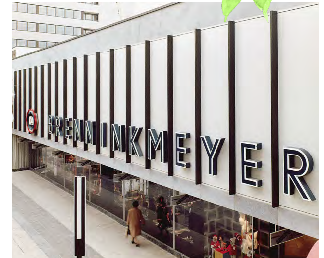
1969 Realisierung des ersten kleinen Fassadenprojektes: C&A Brenninkmeyer in Leverkusen, Deutschland – eine Einfachstverkleidung mit ungeformten Platten
