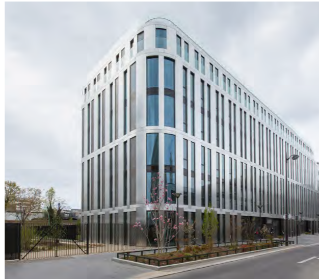
VIEW in Paris, Frankreich NF HQE™ Zertifikat Exceptional & BREEAM® Zertifikat Excellent ALUCOBOND® PLUS naturAL Line © Baumschlager Eberle Architekten & Ooshot
